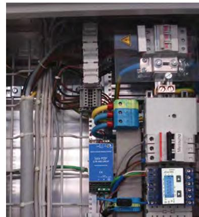
▲ Eingebaute Stromwandler direkt im Kabelkanal
