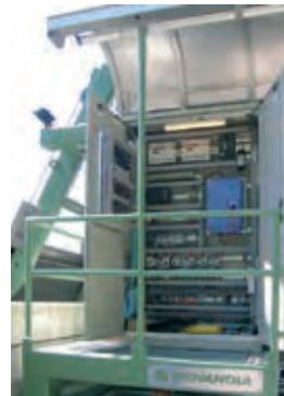
Mobiler Schwemmgutrechen mit Saia®PCD Steuerung
