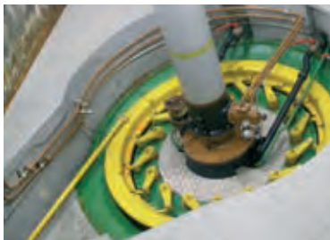
Francis-Turbine mit 800 kW Generator
