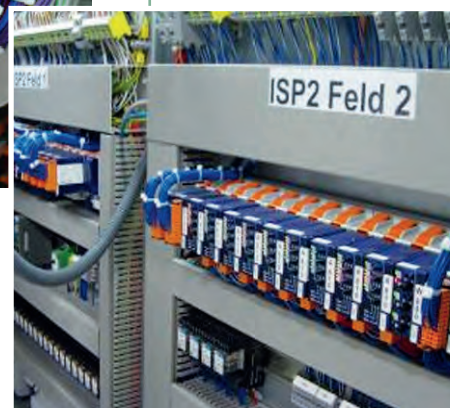
▶ PCD3 mit Ausgangsmodulen inkl. Handbedienung
