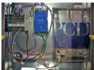
◀ PCD1.M2120 EIB/Web-Anbindung an bestehendes EIB-Netzwerk
