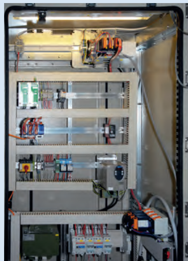
Schaltschrank nach dem Umbau
