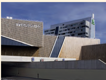
Migros Westside Bern: Hier werden SaiaVisi.Plus Leitsysteme eingesetzt.
