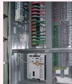
Armoire électrique de faible profondeur regroupant une sous-station Saia®PCD2 et une extension d'E/S locales PCD3. LIO (au centre du bureau)
