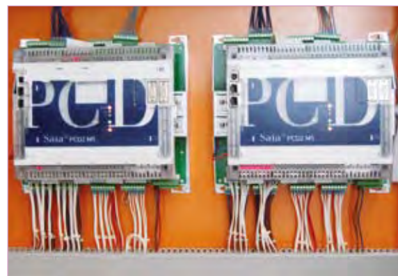
L'armoire, avant et après transformation : à gauche, automates Staefa ; à droite, conversion Saia-Burgess Controls avec automates PCD2.M5540
