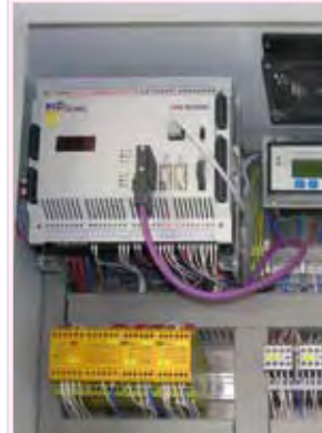
Un Saia®PCD2.M480 contrôle tous les processus de la salle blanche
