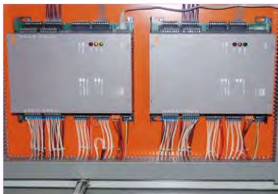
L'armoire, avant et après transformation : à gauche, automates Staefa ; à droite, conversion Saia-Burgess Controls avec automates PCD2.M5540
