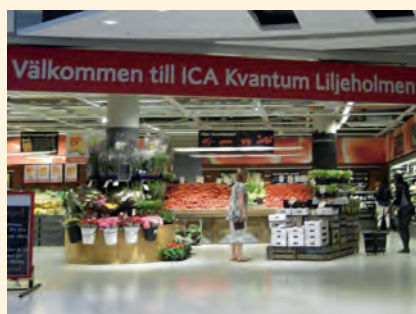
Quatre machines frigorifiques installées dans un supermarché en Suède sont surveillées avec Saia Visi.Plus.
