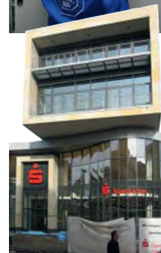
▲ Exemple d'une solution d'automatisation exemplaire au sein d'une Sparkasse allemande
