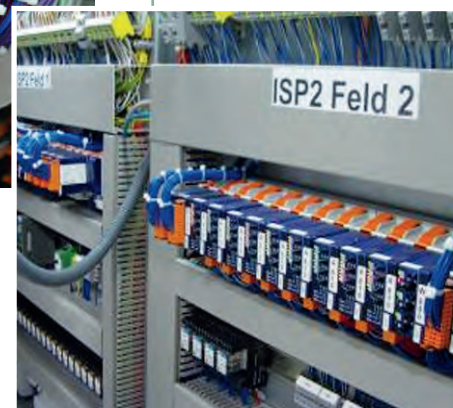
▶ PCD3 avec modules de sortie comprenant une commande manuelle
