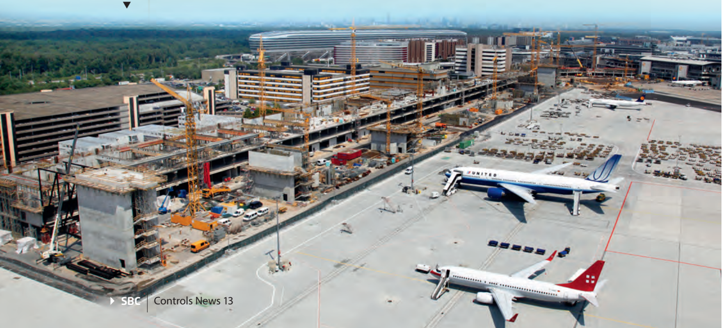
Chantier du terminal A-Plus de 790 m de long
