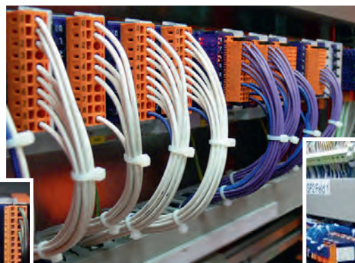
▲ PCD3 avec modules E/S pour capteurs / actionneurs conventionnels
