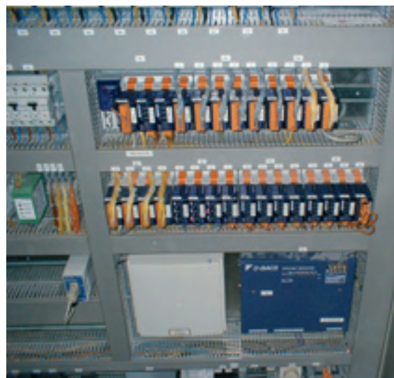
Quadro elettrico con stazione Saia®PCD3 BACnet® (in alto) e gateway D-BACS di Daikin (in basso)
