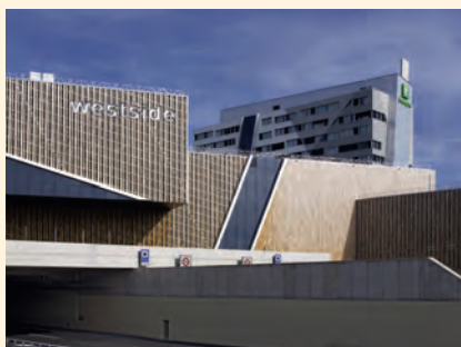
Migros Westside di Berna: un caso di impiego dei sistemi di controllo SaiaVisi.Plus.
