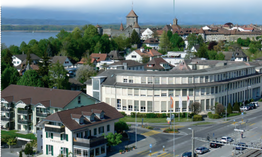
▲ Quartier generale di Saia Burgess Controls, Murten/Svizzera
