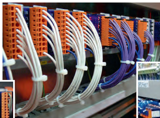
▲ PCD3 con moduli I/O per sensori/attuatori convenzionali
