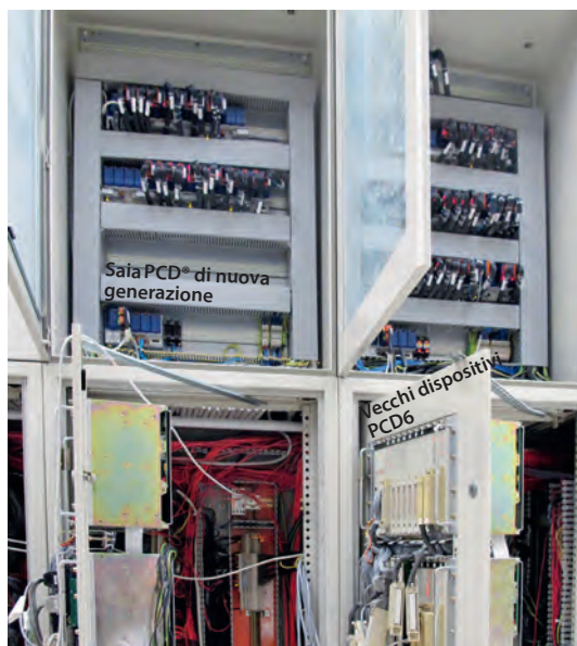
▲ Immagini dei quadri elettrici nuovi (in alto) e vecchi (in basso). Il nuovo quadro elettrico con PCD3 è stato installato e testato, senza dover fermare la produzione gestita dai "vecchi" dispositivi PCD6
