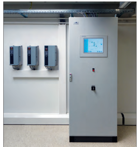
▲ Quadro di controllo del sistema di ventilazione per la formazione (certificato POM Gold)
