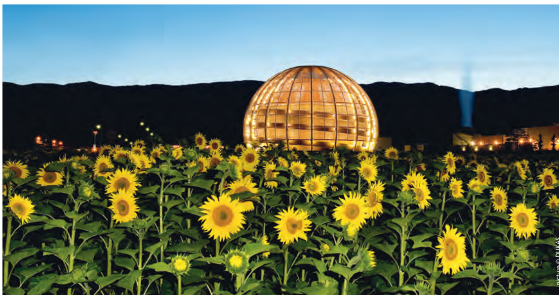
▲ Edificio di ricevimento visitatori. Gestione dell'illuminazione con Saia PCD®
