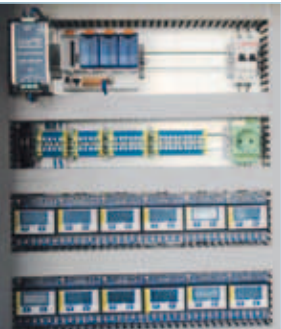
42 Saia® S-Bus-energiemeter en Saia®PCD3.M3120-besturing voor het registreren van energie in het computercentrum van de luchthaven
