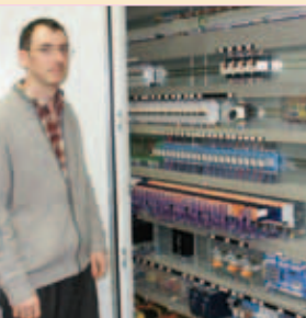
Christian Steins gunt ons een blik in de besturingskast, met in het midden de omvangrijke I/O van de PCD3.
