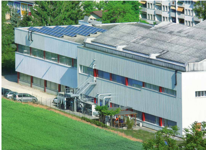
Werk 2: Produktion SMD und Geschäftsbereich Kleingeräte. Solar- anlage mit 11 kWp für «grüne» Klimati- sierung
