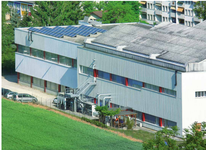
Site 2 : Domaines d'activités : Production CMS et petits appareils. Centrale solaire de 11 kWc pour une climatisation « verte ».
